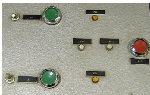
6. ábra: az egyfázisú próbatranszformátor vezérlőpultjának kezelőszervei
